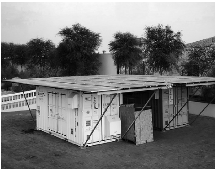
Sestava dvou kontejnerů zařízení S.A.W.E.R. se střešní solární instalací u farmy při zkušebním provozu
