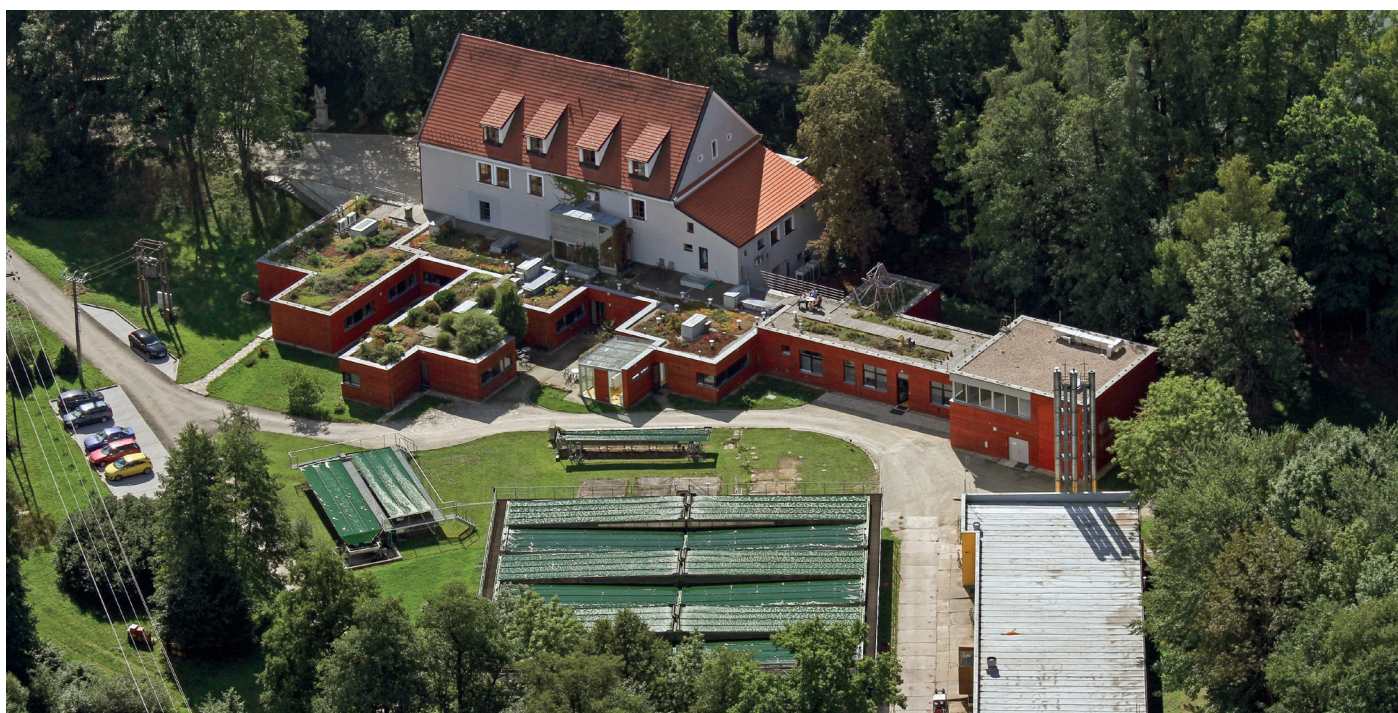
Areál Mikrobiologického ústavu – Centra ALGATECH v Třeboní u Opatovického rybníka. K renovované historické budově mlýna z doby Jakuba Krčína byly přistavěny přízemní buňky laboratoří. Na leteckém snímku dole jsou patrné solární systémy pro kultivaci řas (foto MBÚ – Centrum ALGATECH)
