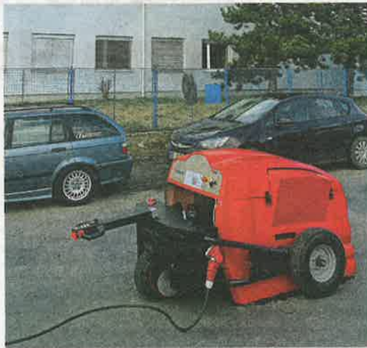
Stroj FT3 firmy Futtec s dvoučlennou posádkou opraví silniční výtluk už během jedné hodiny
